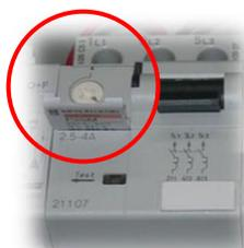
Deberá ajustar el disyuntor magneto-térmico a la intensidad nominal de la bomba especificada en su placa de características. Compruebe con una pinza amperimétrica que el consumo es normal. De no ser así compruebe el sentido de giro del motor, o si sufre alguna avería, agarrotamiento...
